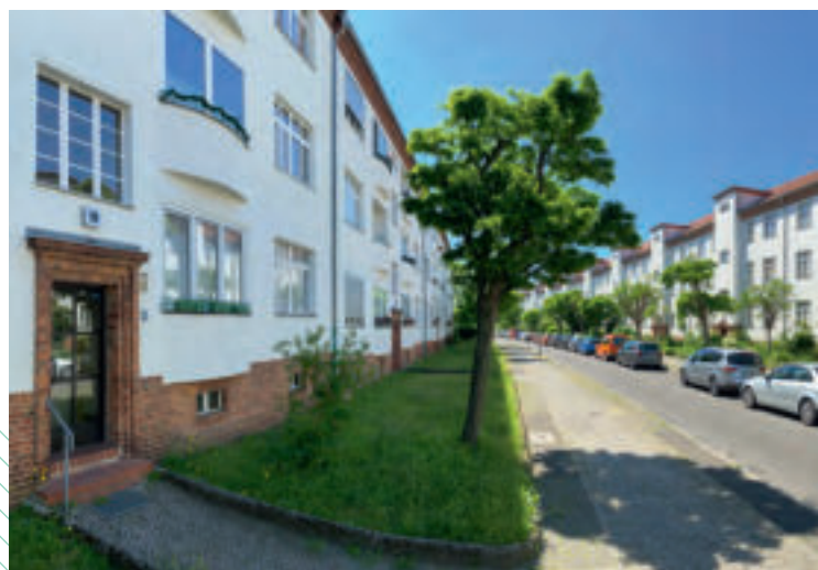
Denkmalgeschützte Gebäude und ruhige Wohnstraßen prägen die Muthesisus- Siedlung in Wittenau
