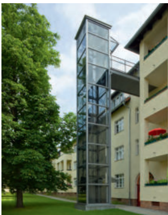
Die neue, modernisierte Geschäftsstelle erreichen die Besucher über einen Außenaufzug
